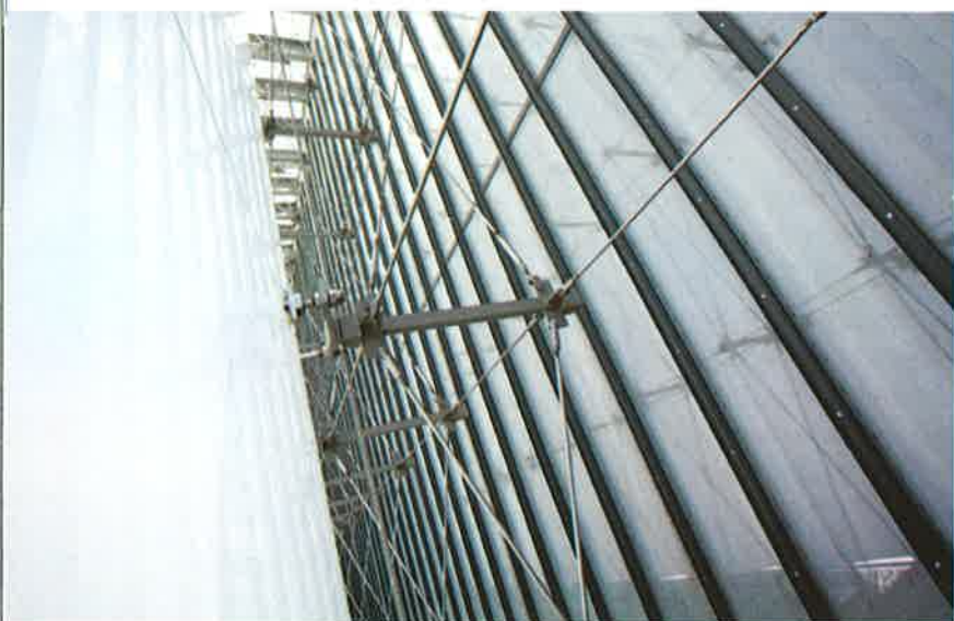
Costituzione della sezione occupata dalla tensostruttura, all'interno dello spazio compreso tra la chiusura di tamponamento e i moduli in vetro strutturale
