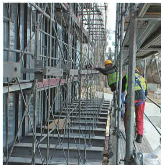
Configurazione geometrica e meccanica dei dispositivi di guida, al passaggio dei cavi tensori, e dei dispositivi di sostegno alle chiusure in vetro, mediante i setti per il collegamento ai pressori esterni e le mensole a sostegno delle lastre in vetro
